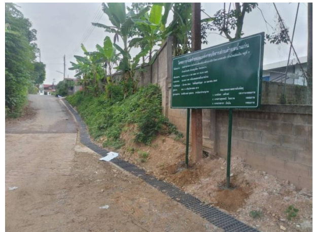
๗. โครงการก่อสร้างวางระบายน้ำคอนกรีตเสริมเหล็กแบบมีฝาปิดตะแกรงเหล็ก หมู่ที่ ๖
