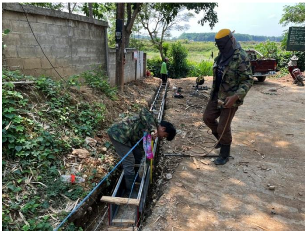
๗. โครงการก่อสร้างวางระบายน้ำคอนกรีตเสริมเหล็กแบบมีฝาปิดตะแกรงเหล็ก หมู่ที่ ๖
