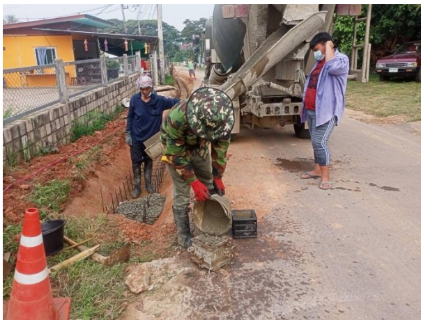
๖. โครงการก่อสร้างวางระบายน้ำคอนกรีตเสริมเหล็กแบบมีฝาปิดตะแกรงเหล็ก หมู่ที่ ๑๐
