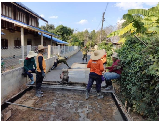
๔. โครงการก่อสร้างถนนคอนกรีตเสริมเหล็กภายในหมู่บ้าน หมู่ที่ ๓
