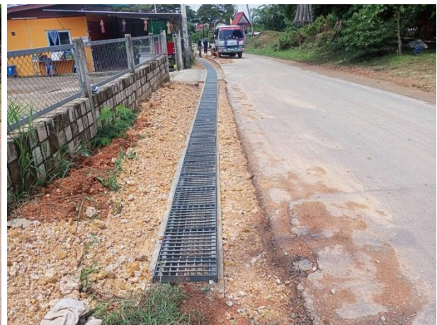
๖. โครงการก่อสร้างวางระบายน้ำคอนกรีตเสริมเหล็กแบบมีฝาปิดตะแกรงเหล็ก หมู่ที่ ๑๐
