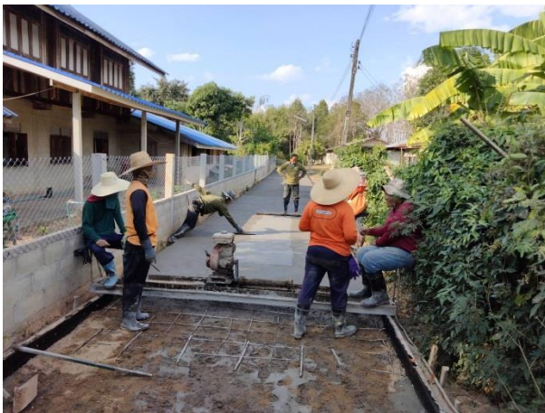
๕. โครงการก่อสร้างถนนคอนกรีตเสริมเหล็กภายในหมู่บ้าน หมู่ที่ ๙
