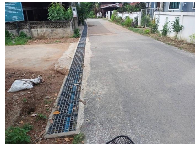
๕. โครงการก่อสร้างรางระบายน้ำ คสล. แบบมีฝาปิดตะแกรงเหล็ก บ้านใหม่ร่มเย็น หมู่ที่ ๖
