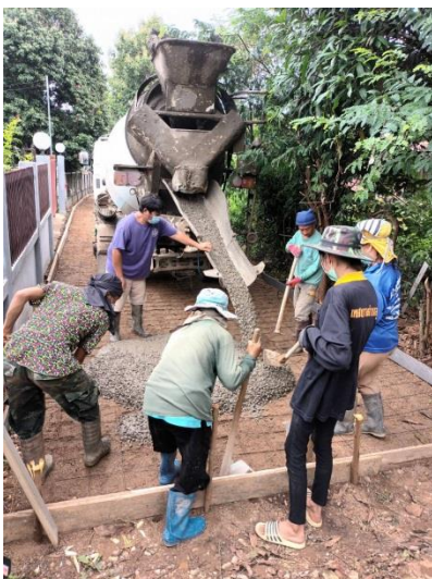
๖. โครงการก่อสร้างถนนคอนกรีตเสริมเหล็กภายในหมู่บ้าน บ้านใหม่ร่มเย็น หมู่ที่ ๖
