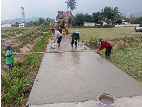
๓. โครงการก่อสร้างถนนคอนกรีตเสริมเหล็กเข้าสู่พื้นที่การเกษตร หมู่ที่ ๔
