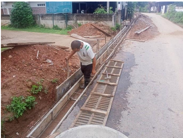
๕. โครงการก่อสร้างรางระบายน้ำ คสล. แบบมีฝาปิดตะแกรงเหล็ก บ้านใหม่ร่มเย็น หมู่ที่ ๖
